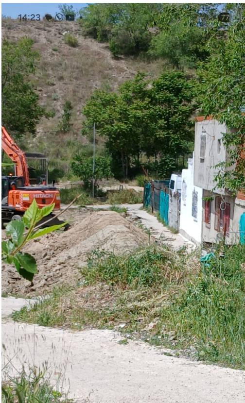
4. Excavadora destruyendo una parcela y camino el 28 de abril de 2026.
