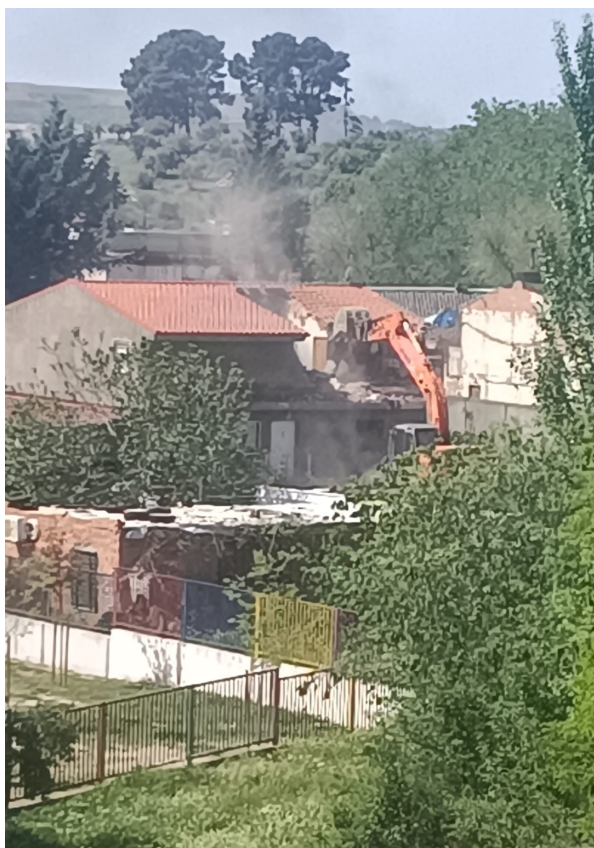
1. Excavadora junto al CEIP Mario Benedetti durante el derribo del 20 de abril de 2026.
